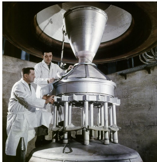
Kiwi B-1-munstycket förbereds för prov
